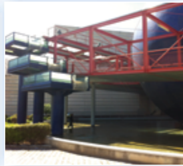
Aménagements hydrauliques de la cité des Sciences de Tunis
